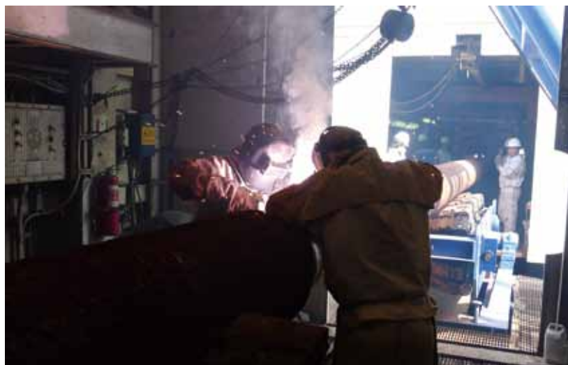
Subsea Pipe Laying 海底管道鋪設
